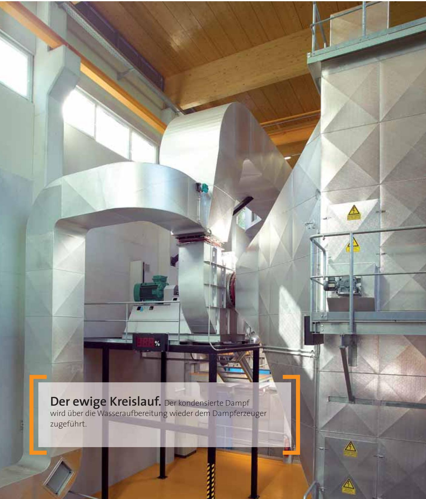
**Der ewige Kreislauf.** Der kondensierte Dampf wird über die Wasseraufbereitung wieder dem Dampferzeuger zugeführt.
