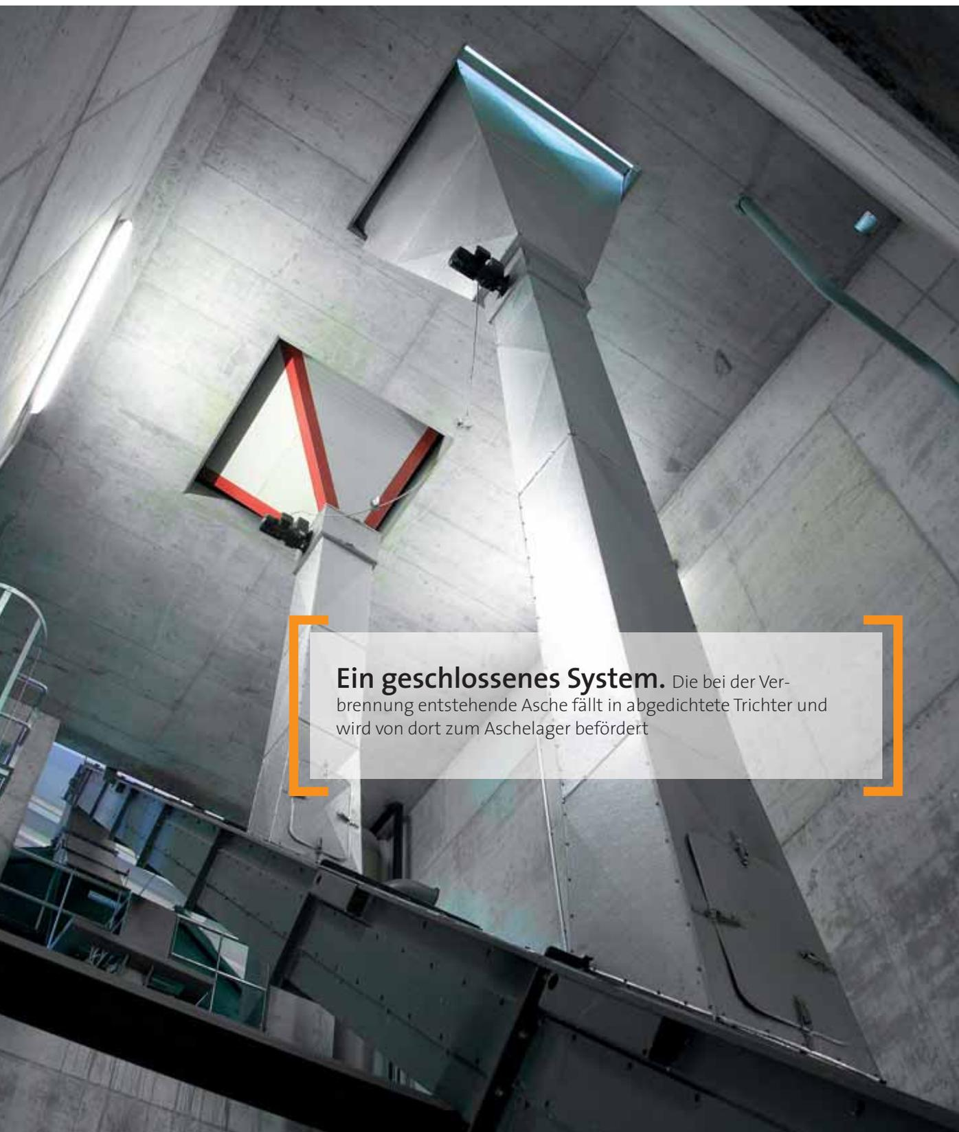
**Ein geschlossenes System.** Die bei der Verbrennung entstehende Asche fällt in abgedichtete Trichter und wird von dort zum Aschelager befördert
